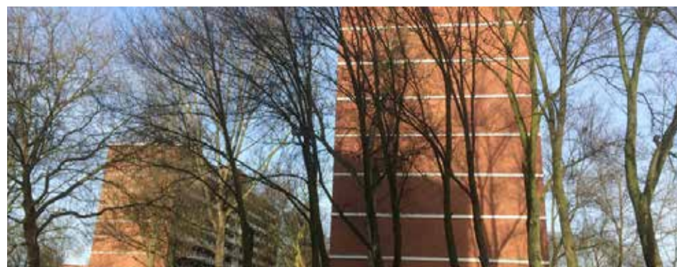
Twee van de te slopen flats
